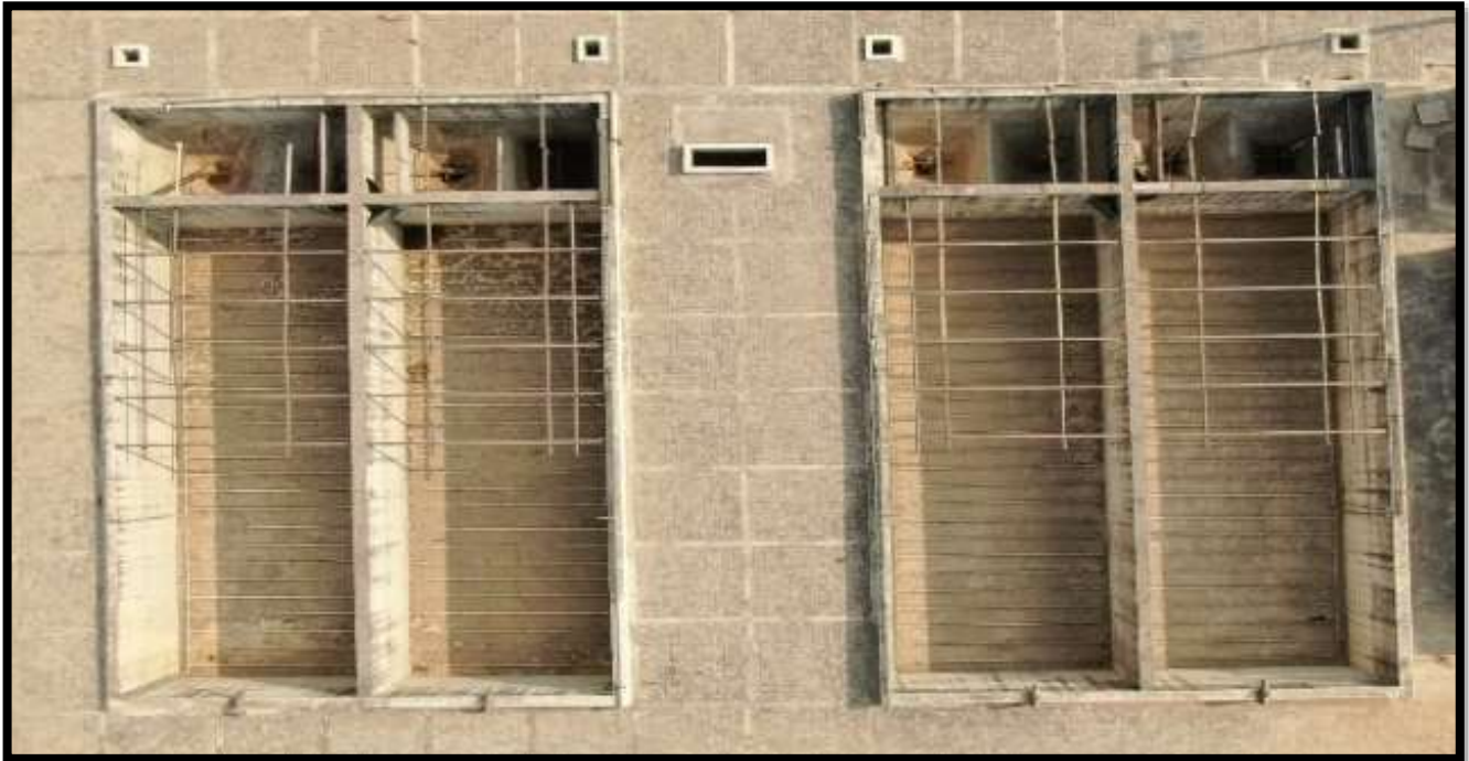
Figura 6. Reactores biológicos de la PTAR.
